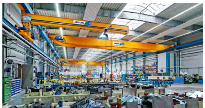
Montage final sur les machines-outils
